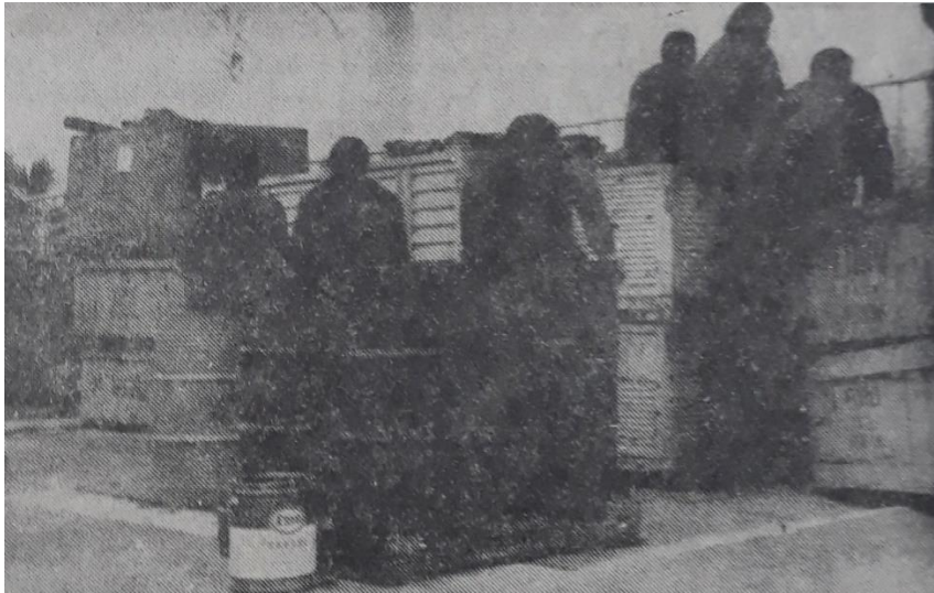
Tanques de combustible en la toma de Transax. Fuente: Córdoba , 3-6-1970.
